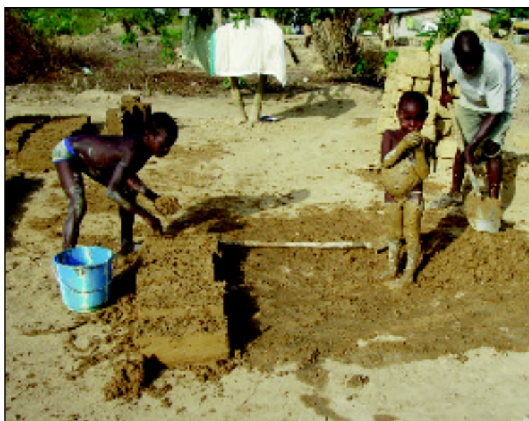
Tegelstenstillverkning vid husbygge uppskattas även av de mindre barnen som tar chansen till rolig lek.
